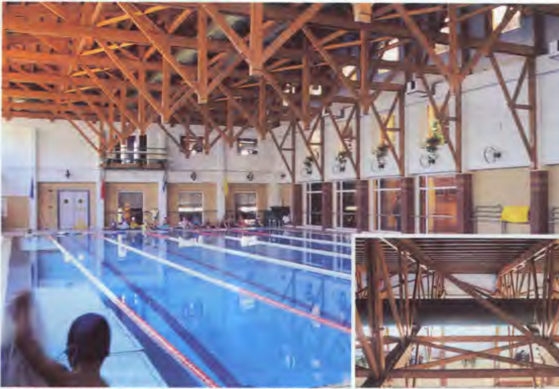
Darüşşafaka Spor Tesisi Kapalı Yüzme Havuzu ve Tesisat Detayı (17,5x3,5 m.)
