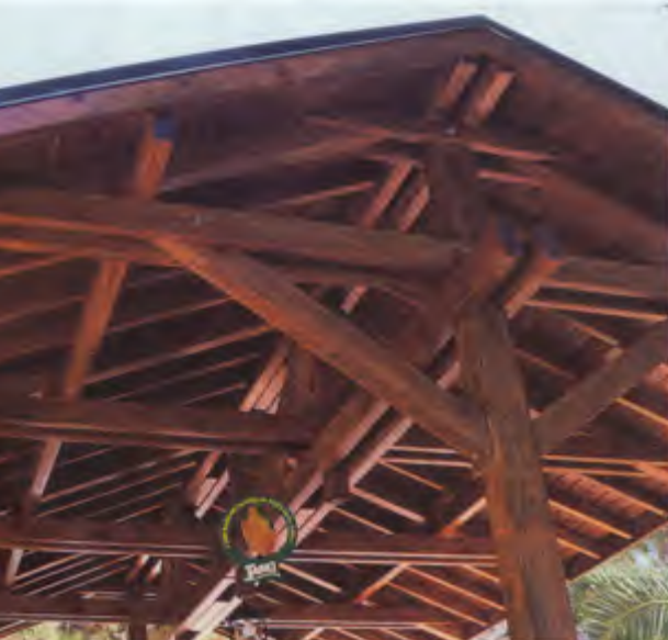
Otel Turquaz Manavgat, açık bar üstü ahşap örtü
