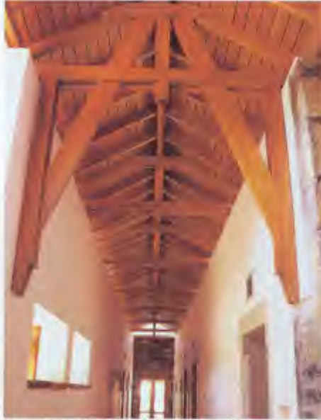
Queen Ada Otelin. Koridor Üstü Ahşap Örtü
