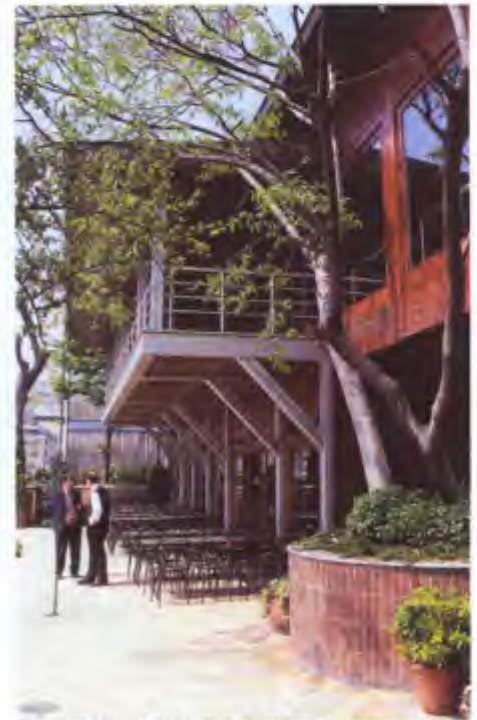
İstanbul Cennet Bahçesi Sosyal Tesisi. Çelik Konstrüksiyon Üzeri Ahşap Kaplama
